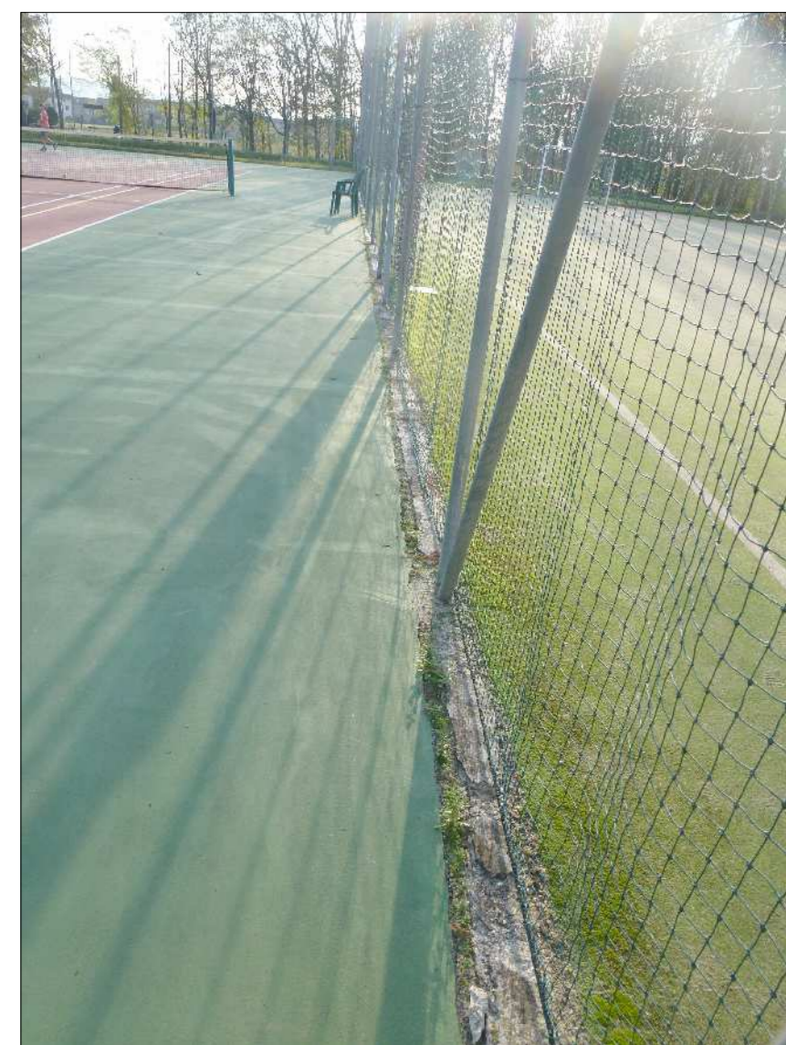
Vista 6 - muretto da rialzare
